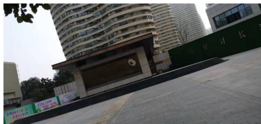
图 4-3 地下车库通风竖井
